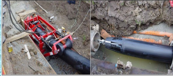
Boru içinden boru geçirme (Slipping lining)
